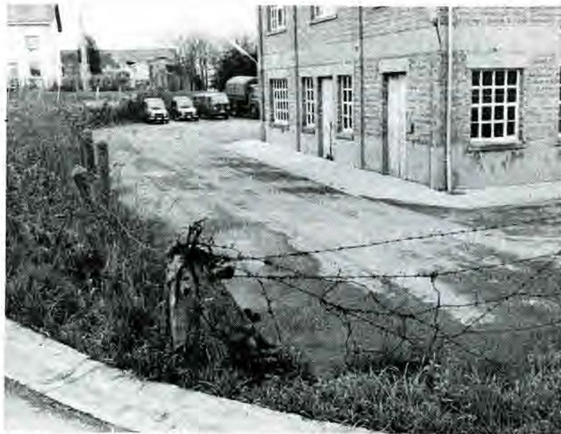
An dieser Stelle ist die Umzäunung im schlechten Zustand. »Ein fünfjähriges Kind könnte ohne Schwierigkeiten und ohne Schrammen in das Gelände eindringen, kommentierte ein Journalistenkollege.
