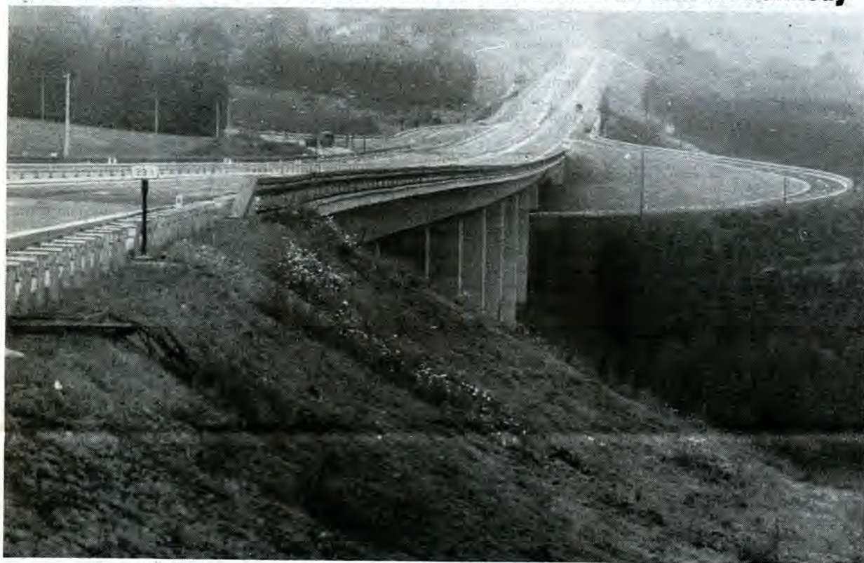
Das größte Brückenwerk der A 27 zwischen St.Vith und Malmedy: Die Talbrücke am Reichtbach
